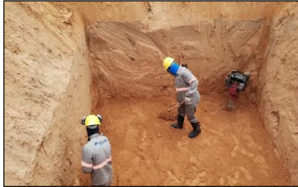
Figura 1. Escavação para fundação antes das chuvas Fonte: Autoria própria (2025)
