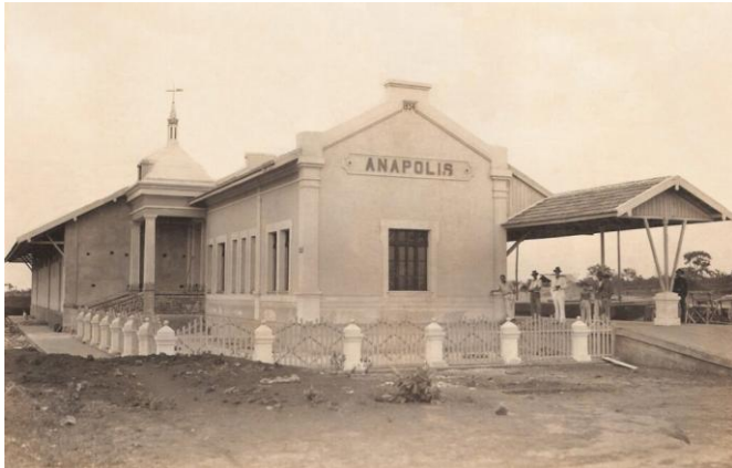
Figura 6 - Estação Ferroviária de Anápolis-GO.
