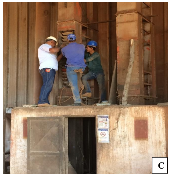
Figura 3: A) Alavanca responsável por fechar as bocas de alimentação no pé do elevador; B) Correia rompida pelo excesso de esforço e C) Manutenção no elevador após a ruptura da correia. Fonte: Arquivo pessoal.
