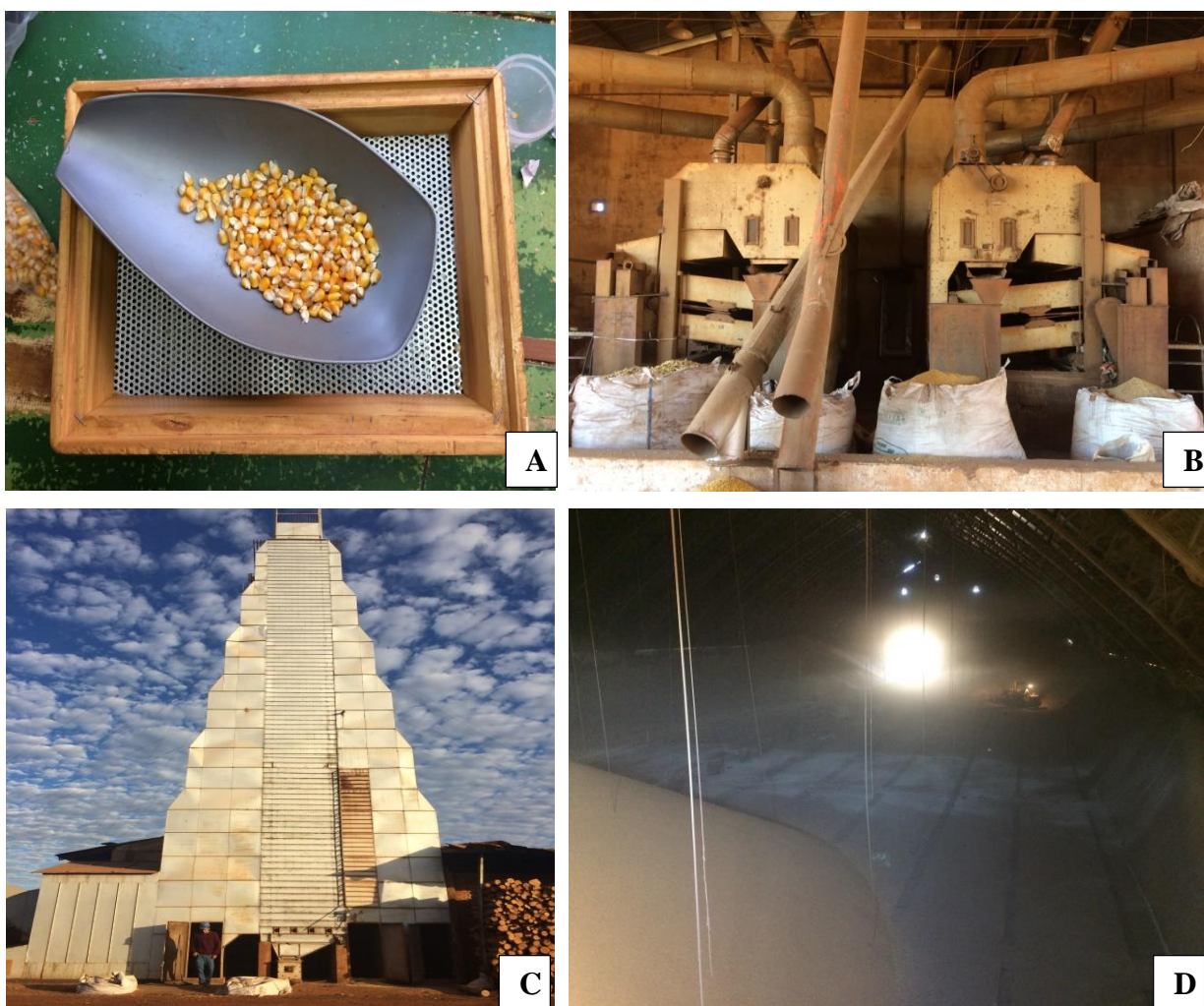
Figura 2 - A) Etapa de Classificação do produto; B) Máquinas de ar e peneiras; C) Secador de fluxo cruzado e D) Início do armazenamento do milho. Fonte: Arquivo pessoal
